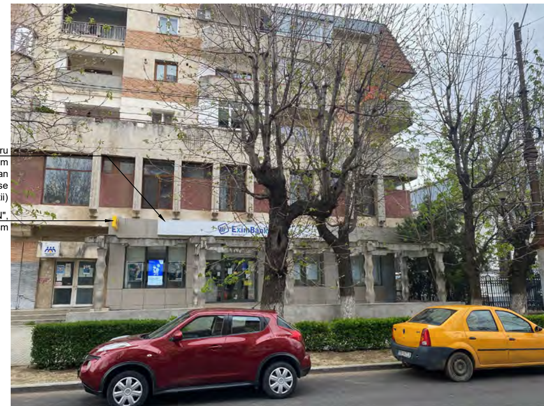
FOTO EXISTENT _ fatada principala
